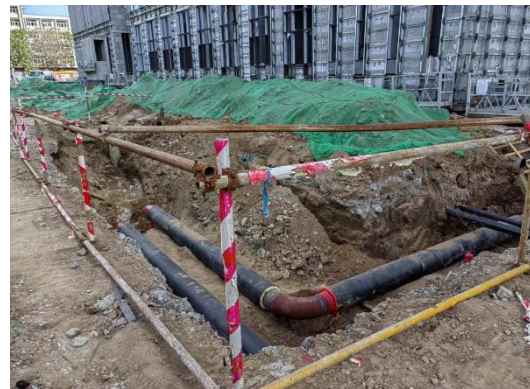
室外管线施工
