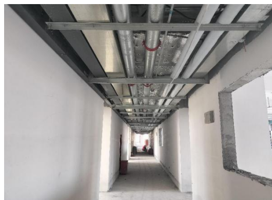
走廊公区施工
