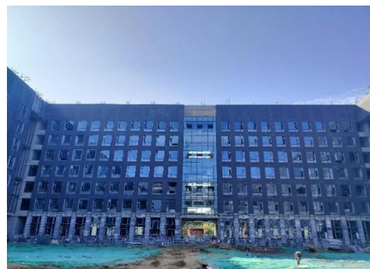
玻璃幕墙施工
