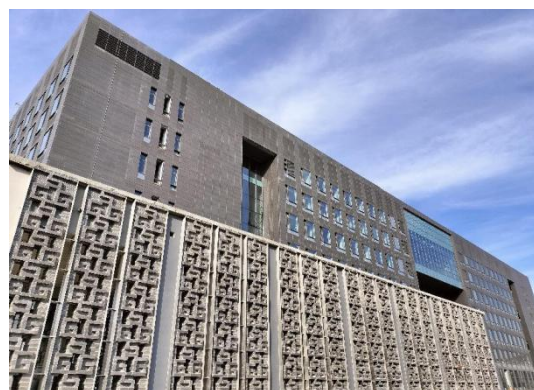
汽车坡道装饰施工
