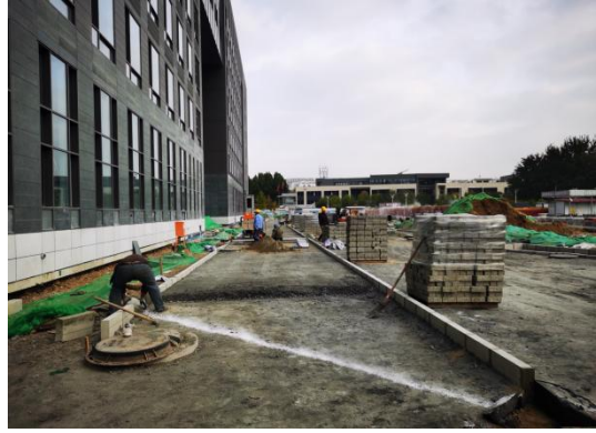
室外工程施工
