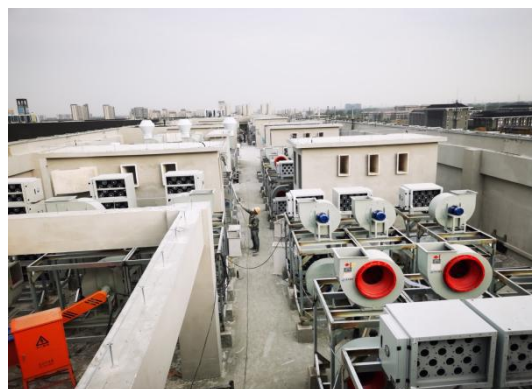
机电专业施工
