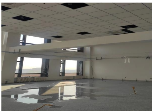
室内吊顶施工
