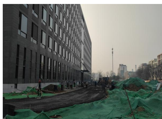
室外工程施工
