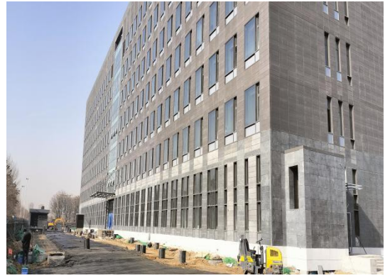
室外工程施工
