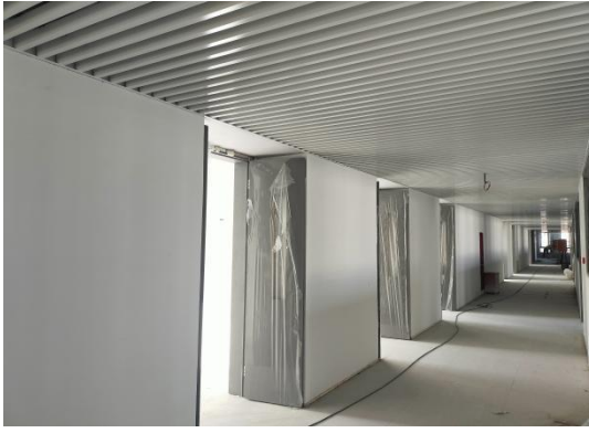
室内装饰施工
