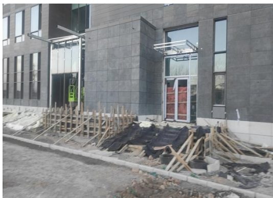
雨棚、门斗施工
