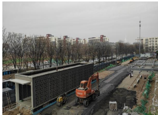
室外工程施工
