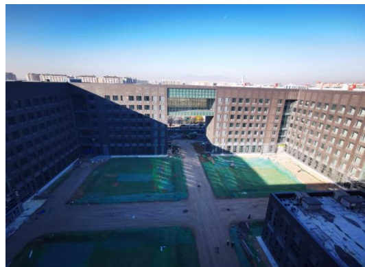
室外工程施工
